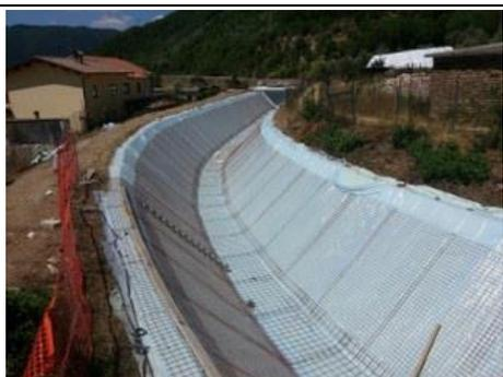
Impermeabilizzazione del canale con posa di geotessile
